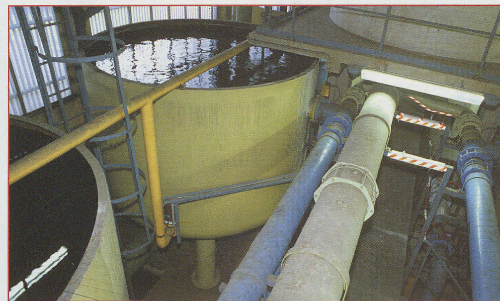
Dans ces citernes, l'eau de la nappe est filtrée et débarrassée de ses impuretés ferreuses.
