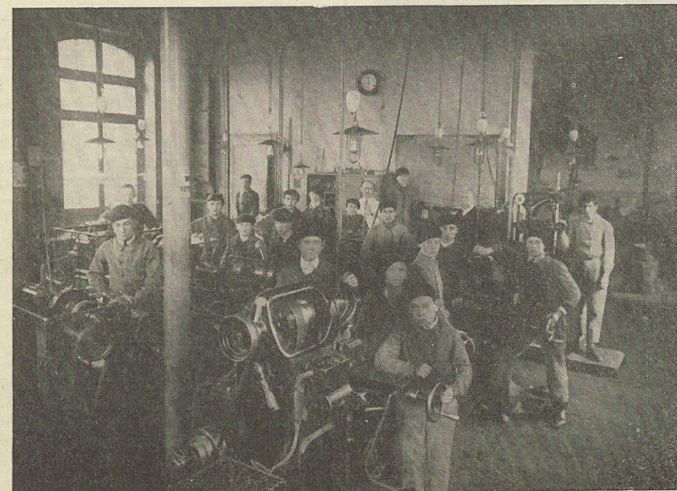
Ecole Professionnelle de la Rue Sadi-Carnot Atelier de Mécanique
