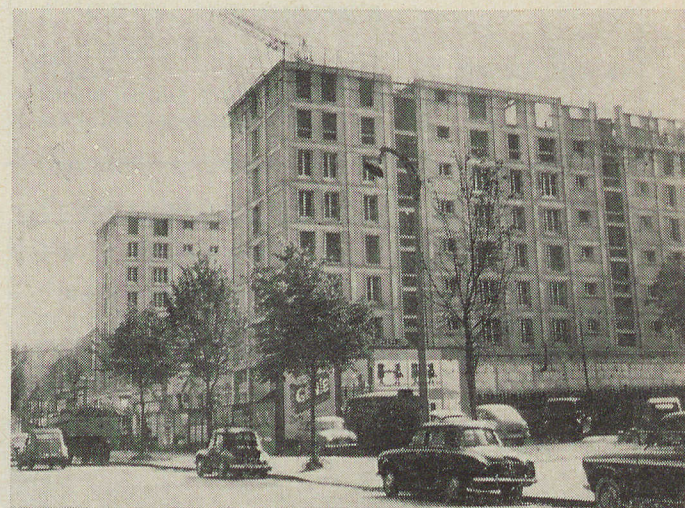
Les acquisitions de Terrains et immeubles pour la construction de logements, d'écoles, 49 millions. (Le chantier des 411 logements place de l'Eglise)
