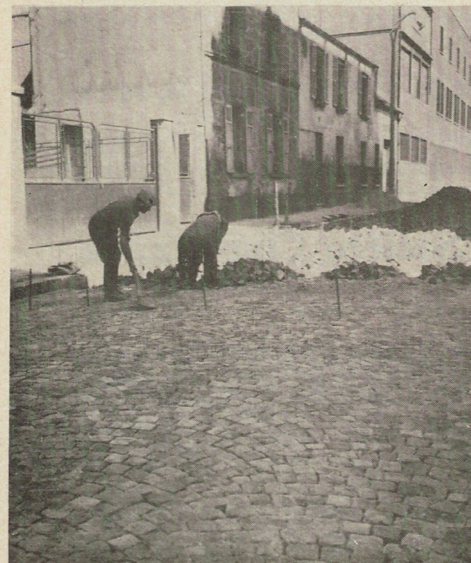
Réfection de la rue Gabrielle Josserand
