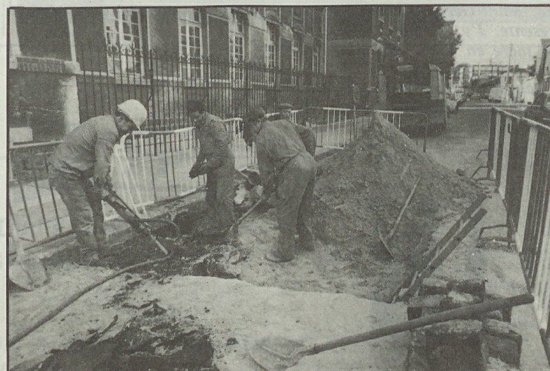
Reprise d'un foutis de 3 mètres de profondeur sous la canalisation de l'égout.
