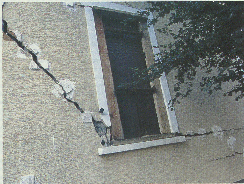
Ce pavillon de la rue Lépine a dû être évacué d'urgence après qu'un effondrement du sous-sol l'ait fait basculer en avant. L'évolution des fissures est inscrite sur chacune des marques de plâtre.
