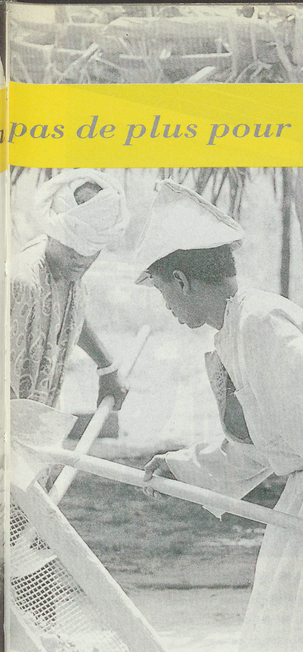
Puis tamisage de cette argile pour la fabrication de briques.
