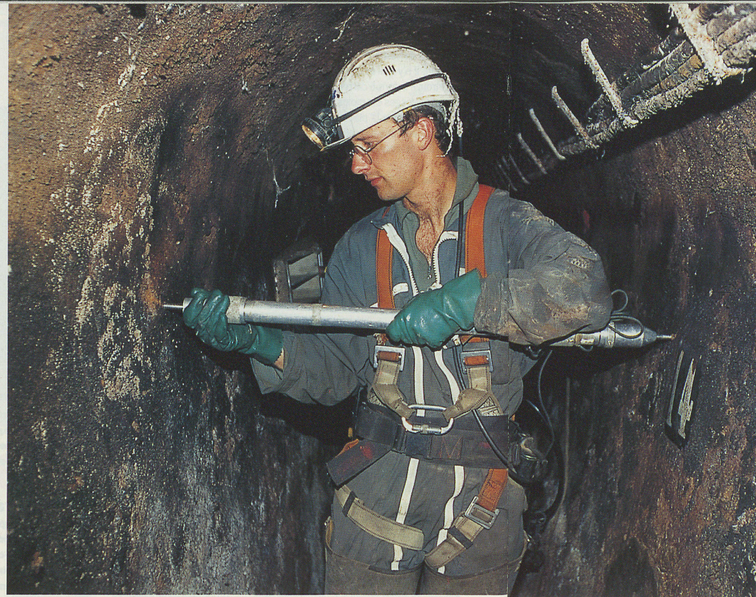
Grâce à ce vérin, des mesures très précises vont permettre de diagnostiquer l'état de l'égout.
