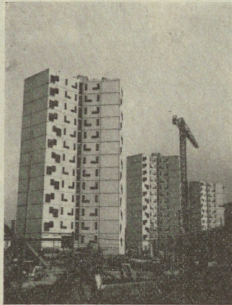
Une vue des 426 logements des « Fonds d'Eaubonne » en voie d'achèvement
